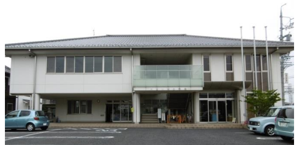
商工会館全景
